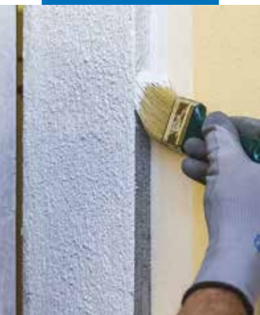
Protección de cornisas de una ventana con Mape-Antique Ecolastic
