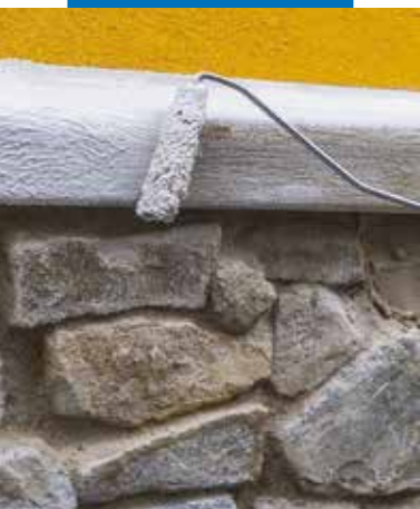
Impermeabilización de la parte superior de un muro con Mape-Antique Ecolastic
