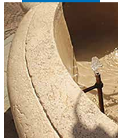
Impermeabilización del vaso de una fuente de piedra
