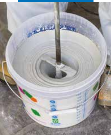
Mezcla de Mape-Antique Ecolastic
